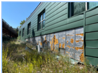
ARC Siding Damage 1.jpg
